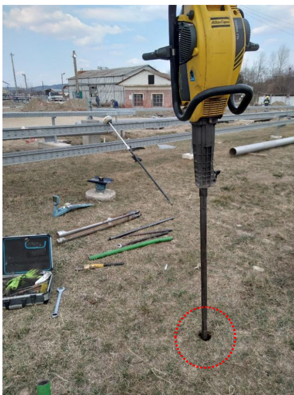
Foto 1. Aspect din timpul de execuție al forajului 1
